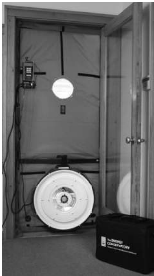
A blower door
